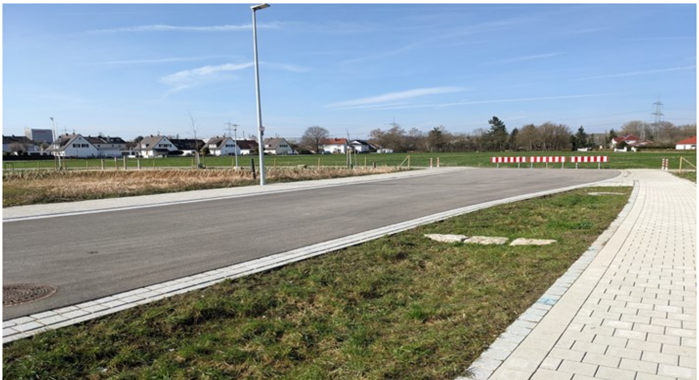
Hier endet derzeit die neue Kranichstraße. Die geplante Weiterführung zur Illerzeller Straße steht in den Sternen und die Reiherstraße ist schon zurückgebaut.
